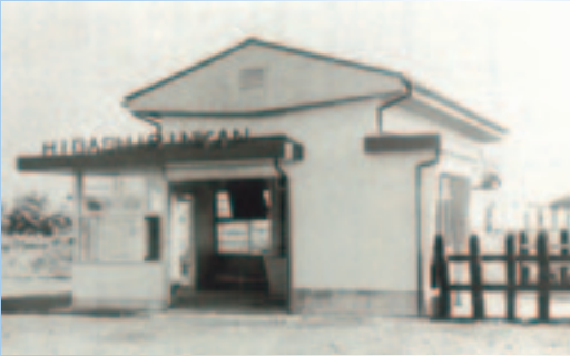
昭和28年新築の東林間駅舎
