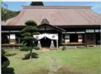
6 小原宿本陣 甲州街道中の宿場本陣として県下で唯一現存する、県の重要文化財で、近くには本陣を紹介した小原の郷がある。
