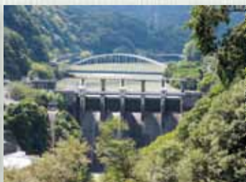
2 相模ダム 昭和22年に完成した神奈川県で最初の大規模な多目的ダムで、発電や県民の水道用水に利用。
