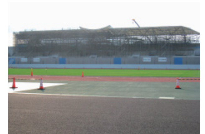
相模原麻溝公園陸上競技場 平成20年11月(メインスタンド建設中)
