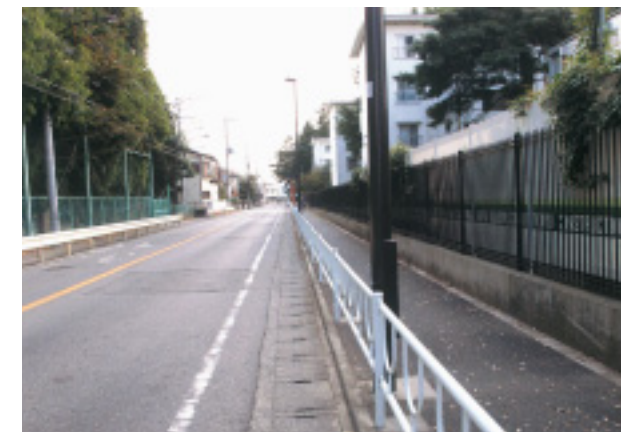
(独)国立病院機構相模原病院 東側歩道
