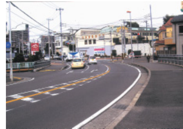
橋の架け替えと道路改良された主要地方道相模原茅ヶ崎線 ちとせ橋付近
