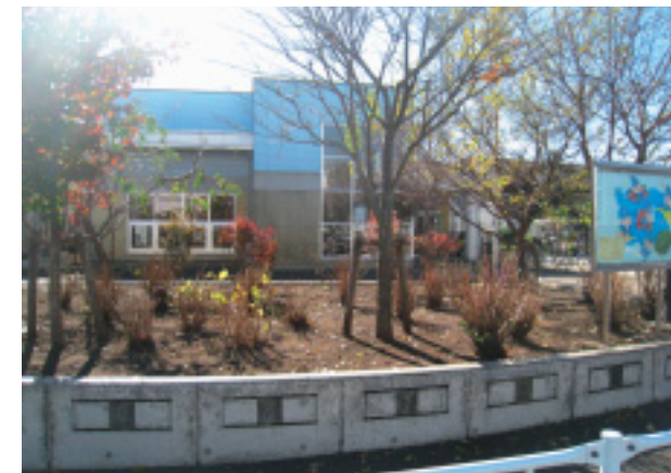
麻溝子どもセンター(平成12年7月開所)
