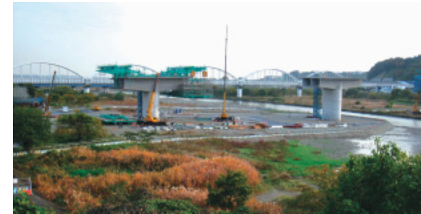
建設が進む「さがみ縦貫道」(仮)相模原インターチェンジ 平成20年11月
