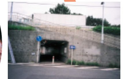
16号線陸橋下に連絡通路開通( H15年 )
