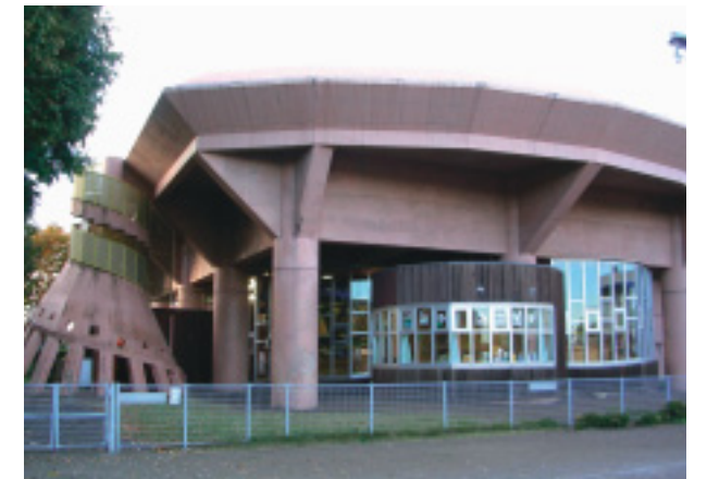
拠点の一角 星が丘こどもセンター
