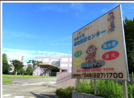
総合防災センターの入口
