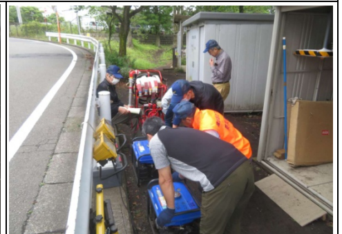
発電機点検の様子
