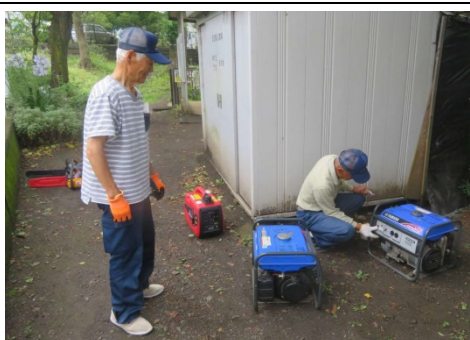
発電機点検の様子
