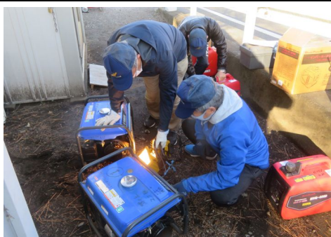
発電機と投光器点検の様子
