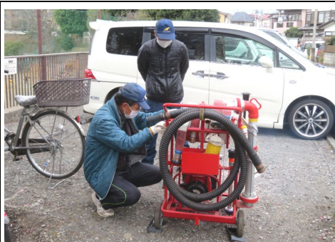
D級ポンプ点検の様子
