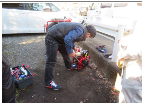
D級ポンプ点検の様子
