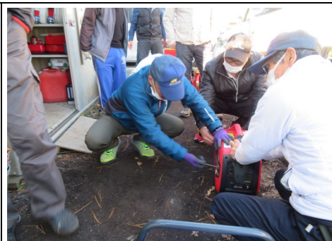
発電機点検の様子
