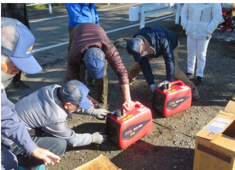
発電機点検の様子
