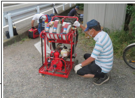
D級ポンプ点検の様子
