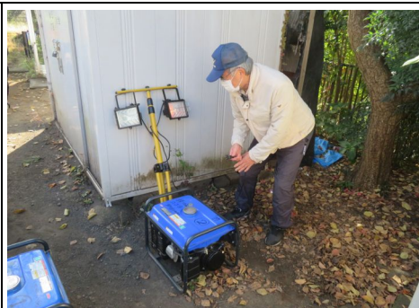
発電機と投光器点検の様子
