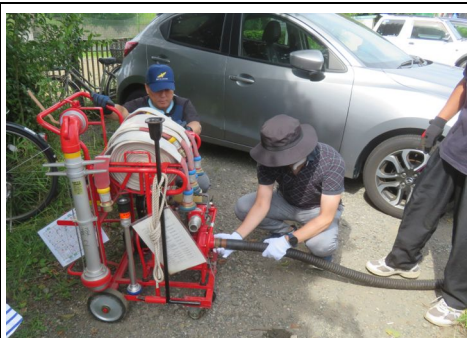
給水口に吸管を結合する様子
