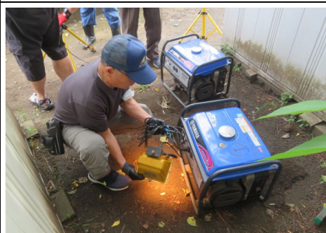
機器点検の様子
