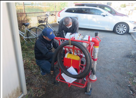
D級ポンプ点検の様子
