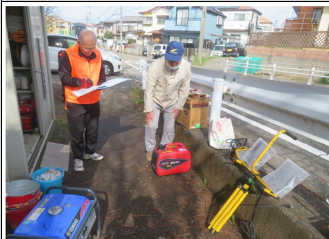
発電機点検の様子
