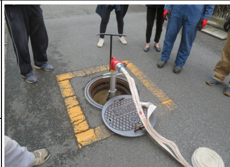
スタンドパイプ取扱い訓練の様子
