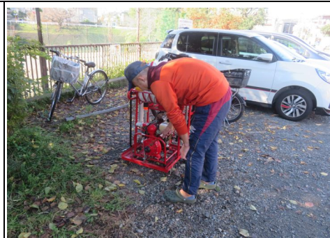
D級ポンプ点検の様子
