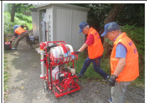
D級消火ポンプ点検の様子
