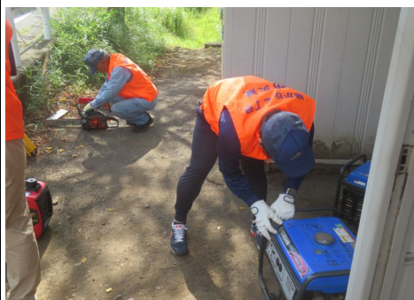
発電機点検の様子
