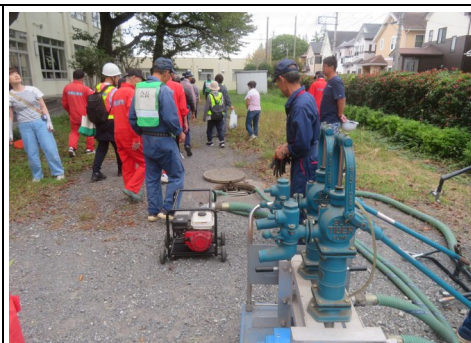
災害時貯水槽見学の様子
