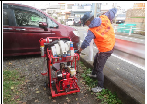
D級ポンプ点検の様子
