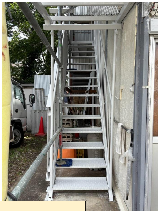
外階段は塗装工事 さび止め+上塗り 2回
