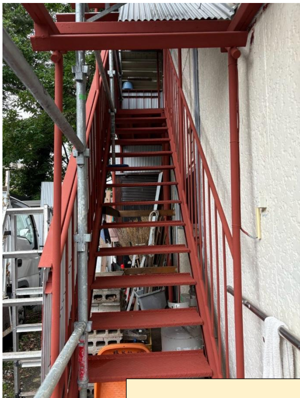
外階段は塗装工事 さび止め+上塗り 2回
