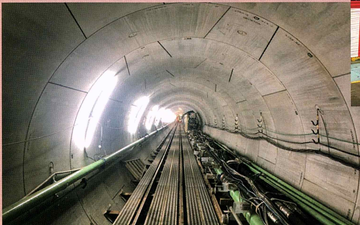
▲鉄筋コンクリートセグメントで覆われた内径3.25mの雨水管内
