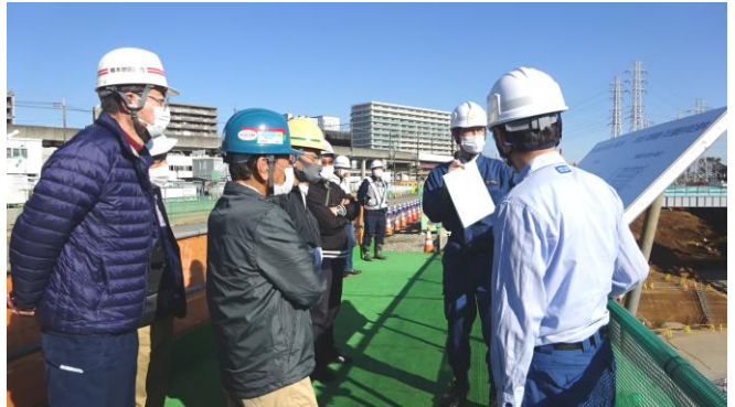
◇工事現場での説明
