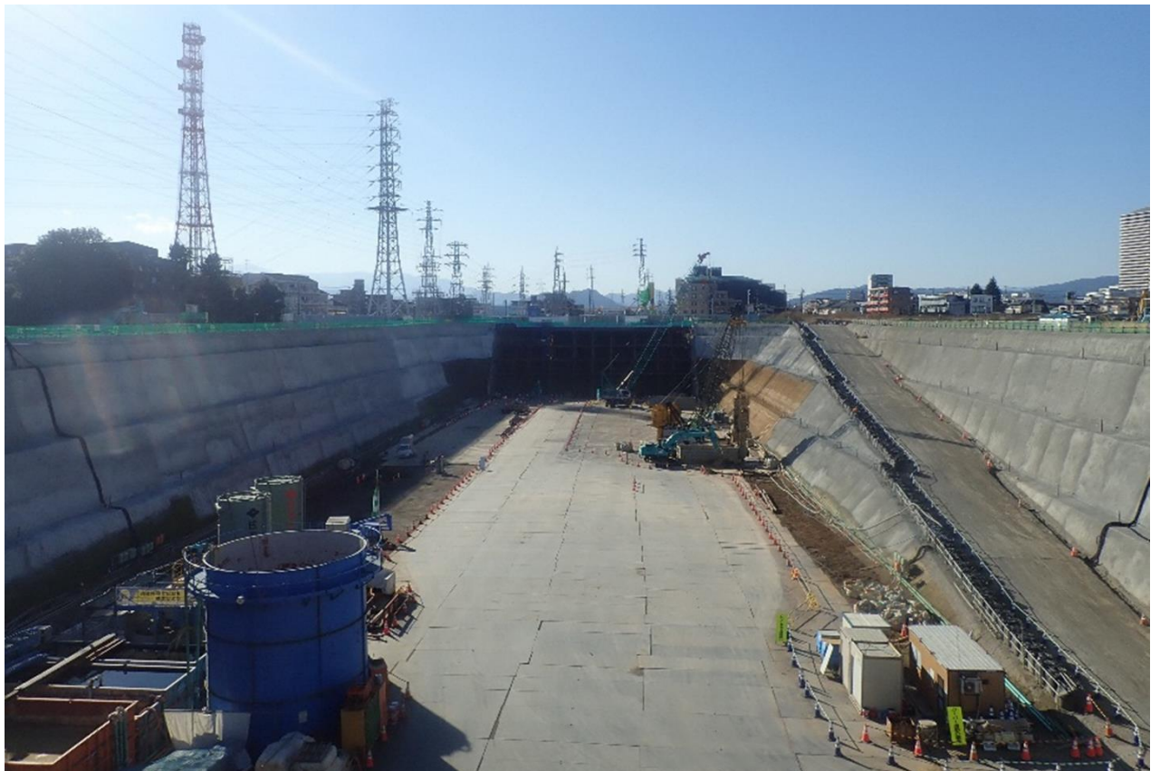
◇神奈川県駅（仮称）…地下約30mまでの掘削準備
