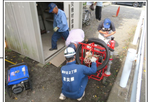
8月度小型消防ポンプ点検の様子
